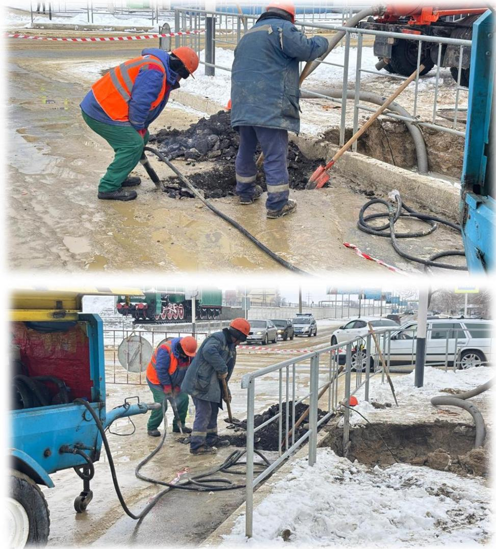
4 февраля 2026 года выполнены работы по замене подземного перехода трубопровода диаметром 108 мм протяжённостью 18 метров по адресу: ул. Абая, 10.
