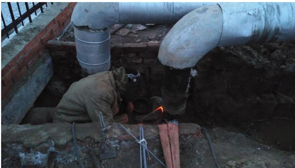
Работники ЦТС сразу же приступили к земляным работам по вскрытию участка подземной прокладки. Работы проводились вручную и механизированным способом, с использованием отбойных молотков. Было демонтировано асфальтовое покрытие на пешеходной дороге, вскрыты бетонные плиты перекрытия по краю автодороги по проспекту Гагарина для обеспечения доступа к поврежденным трубам. Работать приходилось непрерывно, выполняя одновременно вскрытие труб и откачку воды с
