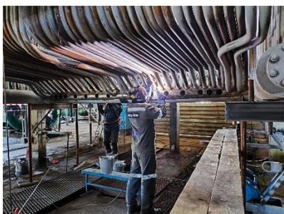
После завершения подготовительных работ, с 24 июля 2024 года, к процессу технического перевооружения котла приступила подрядная организация АО "ГК "ЕКС". На данный момент выполнено около 80% работ по трубным частям агрегата. Впереди - гидравлические испытания, монтаж теплоизоляции и обмуровки, установка горелочных устройств и прочие ответственные этапы.
