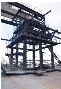
Следующим шагом стала масштабная реконструкция водогрейного котла №1 (ПТВМ-50 №10). С 1 по 12 июля 2024 года, был проведен демонтаж водогрейного котла ПТВМ-50 №1 для его дальнейшего технического перевооружения. Работы по демонтажу выполнялись собственными силами сводной бригады ТЭС.
